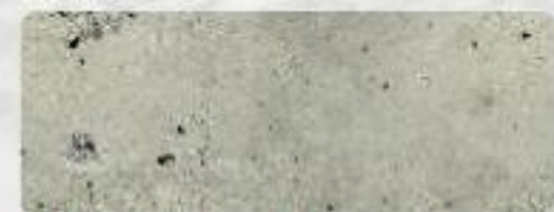
Pavimentazione in cemento, uniforme e pulita, secondo la EN13509
