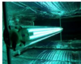
Figura D.9.1\_1 Nei sistemi UVC inseriti nei condotti di canalizzazione dell'aria le lampade sono disposte in modo da ottimizzare l'irraggiamento del flusso d'aria al fine di impartire la dose prevista di radiazione UVC.
